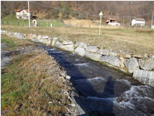
Tratto rivestito e difeso a monte del ponte SP39.
