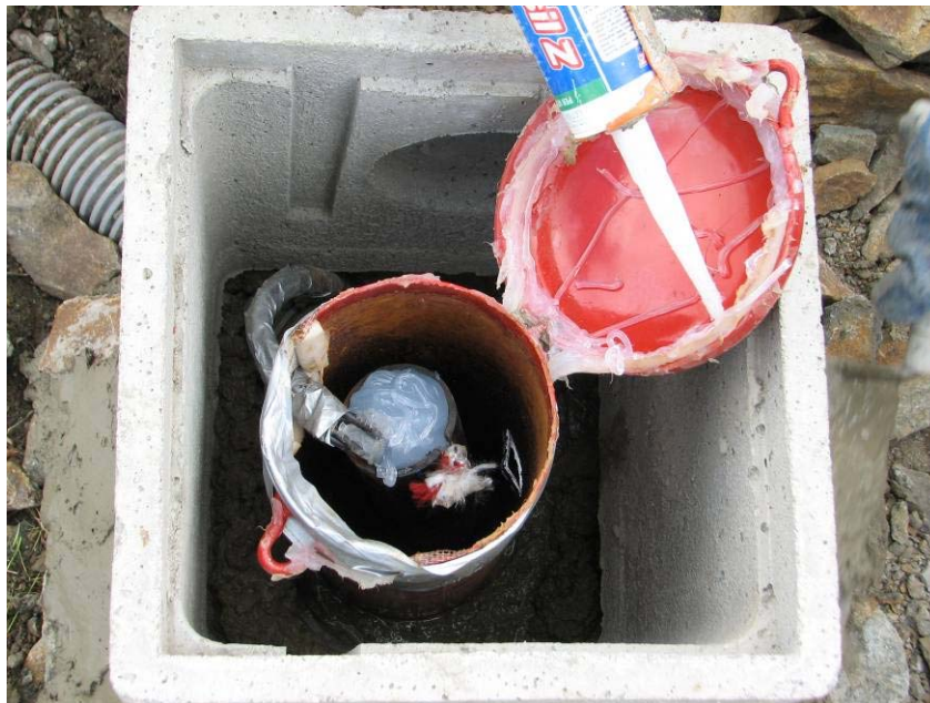
Sito del Passo dei Salati – Istituto Mosso (Alagna Valsesia, VC) – Sopraelevazione della testa-foro con manicotto in HDPE e sigillatura della giunzione con annegamento in malta cementizia (in alto a sinistra), preparazione manuale dei drenaggi nella protezione metallica della prolunga (in alto a destra) e sigillatura del pozzo con silicone (foto: L. Paro, settembre 2011)
