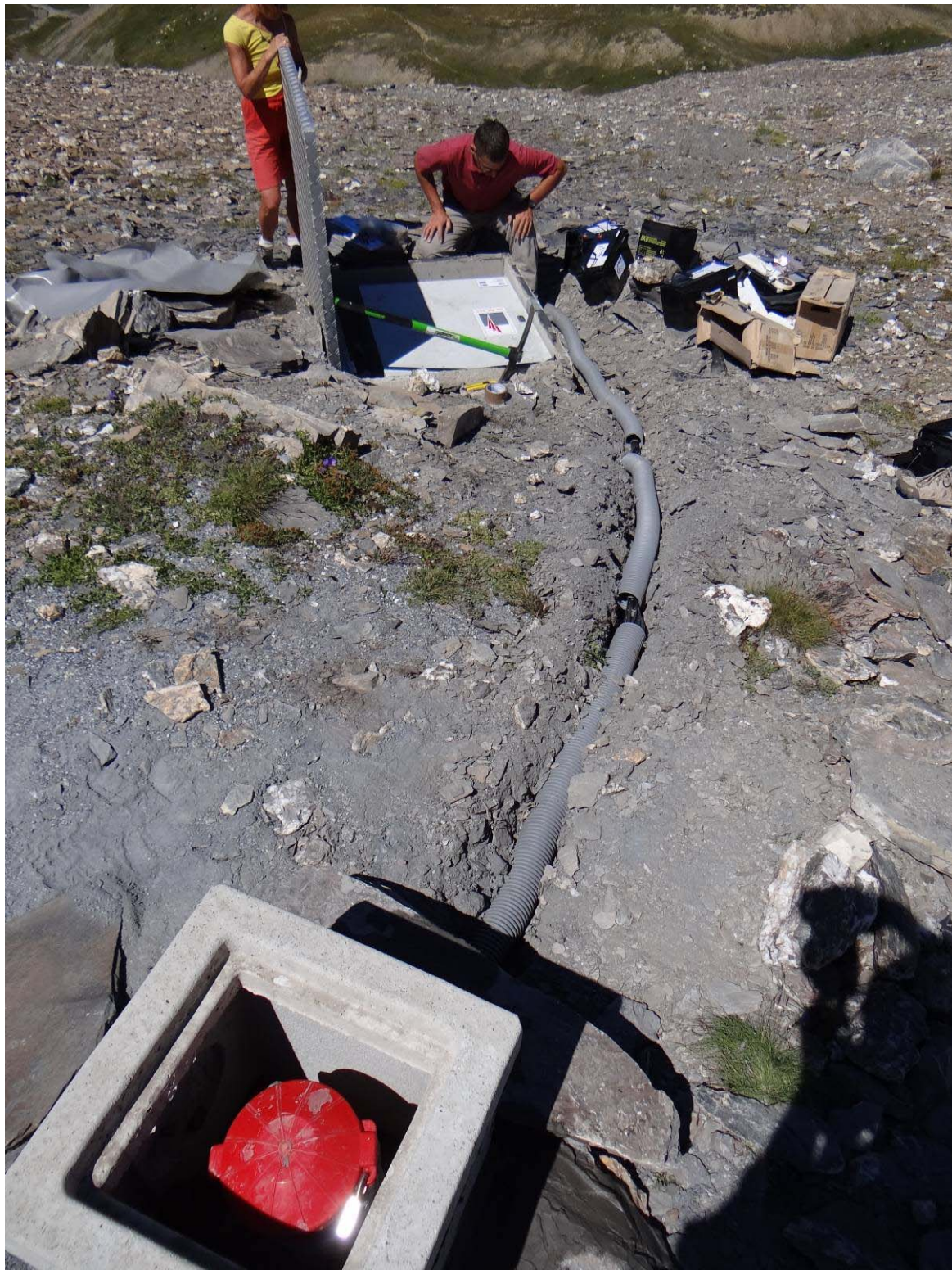
Sito de La Colletta (Bellino, CN) – Sistemazione del tombino testa-foro ed interrimento del cavedio (foto: G. Moletta, agosto 2012)
