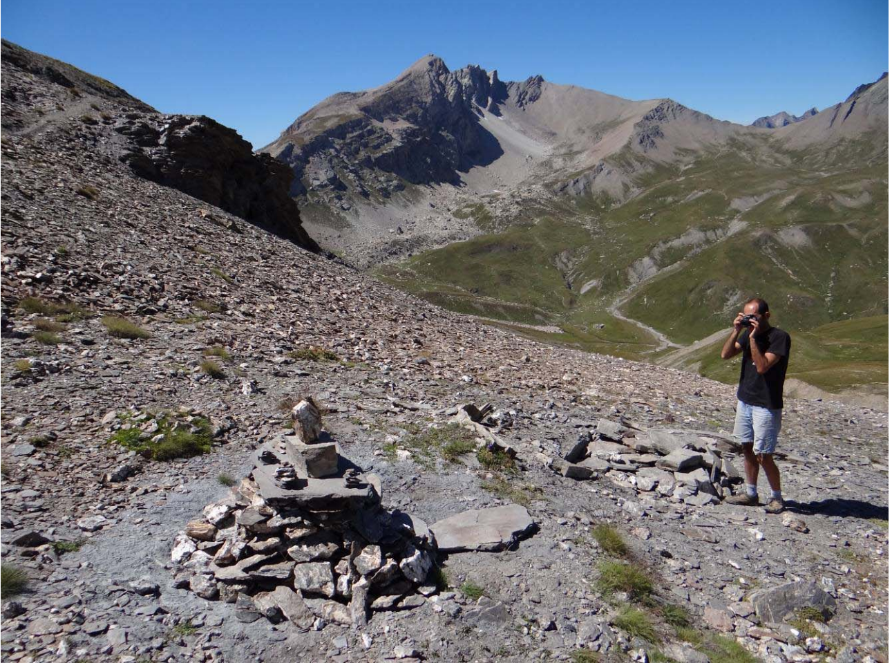
Sito de La Coletta (Bellino, CN) – Completamento della stazione con mimetizzazione, utilizzando pietre locali, del tombino testa-foro e del tombino del datalogger e delle batterie (foto: L. Paro, agosto 2012)
