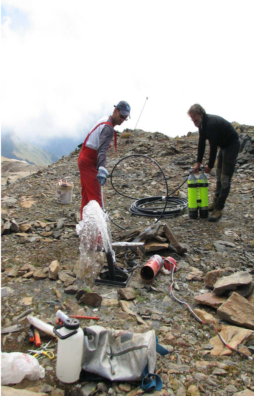
Sito del Passo dei Salati – Istituto Mosso (Alagna Valsesia, VC) – Estrazione dell'acqua dal pozzo profondo 5 m tramite aria compressa (foto: L. Paro, settembre 2011)
