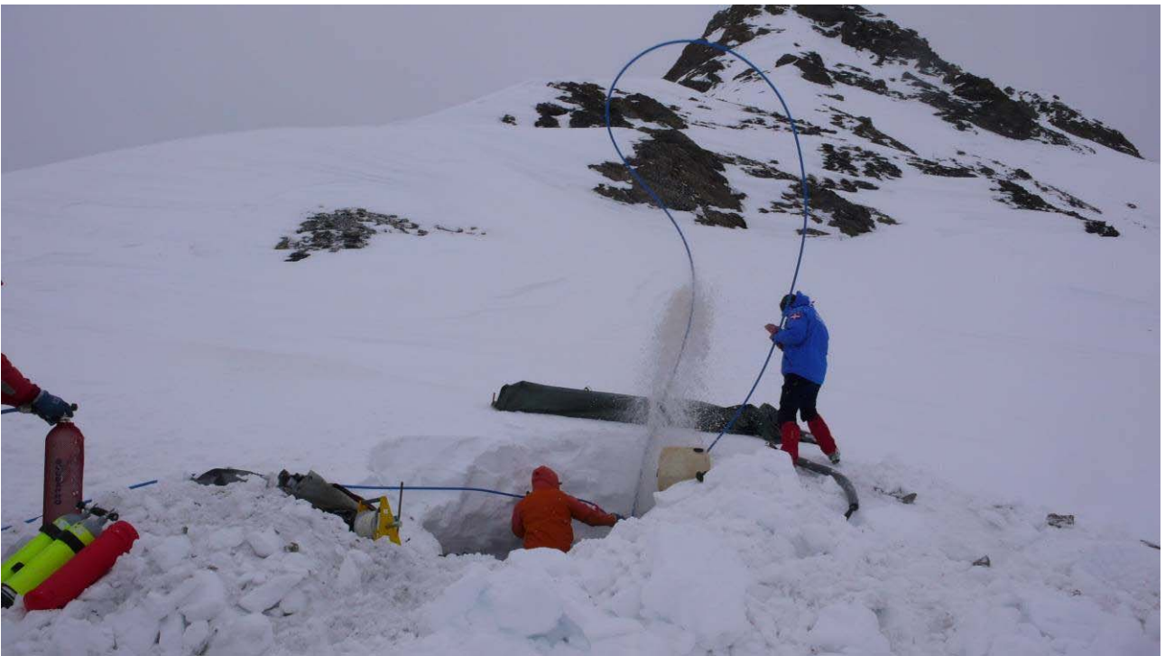
Sito de La Colletta (Bellino, CN) – Spurgo del pozzo profondo 30 m tramite acqua calda per sciogliere il ghiaccio (in alto) ed estrazione dell'acqua con aria compressa (foto: P. Mattiel, dicembre 2011)
