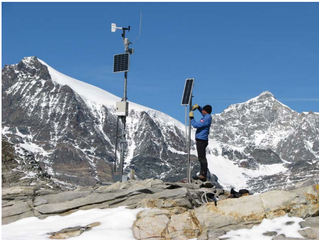
Sito del Passo del Monte Moro (Macugnaga, VB) – Stendimento del cavo di alimentazione ed installazione del nuovo pannello solare in prossimità della stazione di monitoraggio per lo snow-drifting (foto: L. Paro – G. Re Fiorentin, agosto-settembre 2013).
