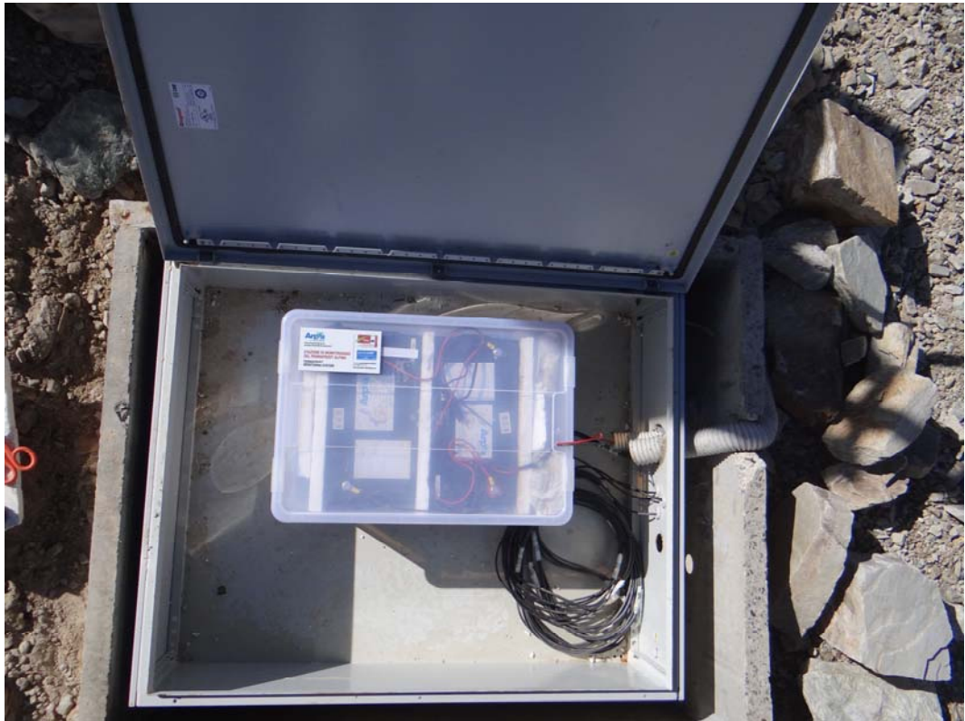
Sito del Colle Sommeiller (Bardonecchia, TO) – Sistemazione tendi-cavi dei tiranti e inserimento delle batterie tampone in scatola di protezione all'interno del tombino (foto: L. Paro, ottobre 2013).
