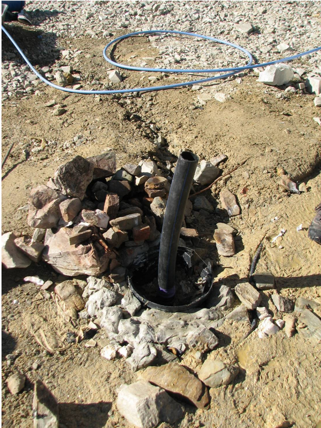
Sito del Colle Sommeiller (Bardonecchia, TO) – Sopralzo della testa-foro con inserimento di una prolunga di tubo in HDPE al tubo del pozzo (foto: L. Paro, ottobre 2010)
