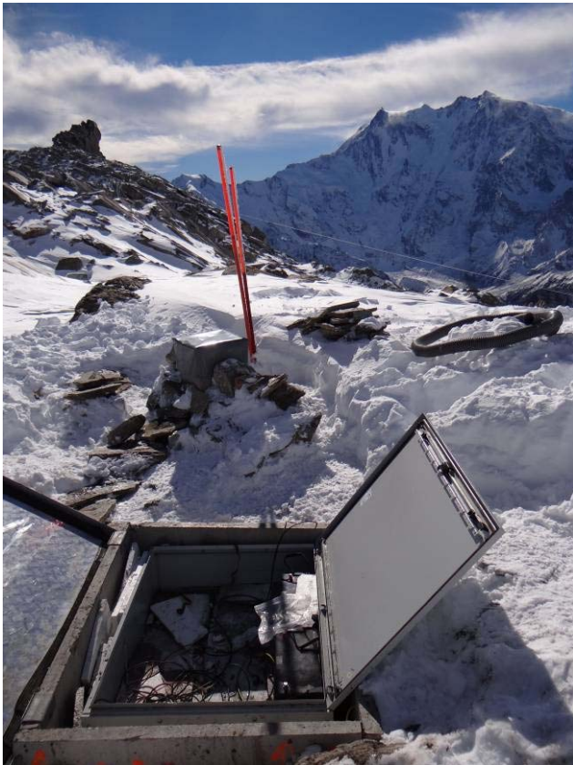
Sito del Passo del Monte Moro (Macugnaga, VB) – Sistemazione delle batterie tampone all'interno del tombino interrato e completamento del tombino della testa-foro del pozzo (a sinistra); completamento della stazione di monitoraggio con chiusura del carter metallico di protezione dei cavi e sistemazione del tirante (foto: L. Paro, ottobre 2012)
