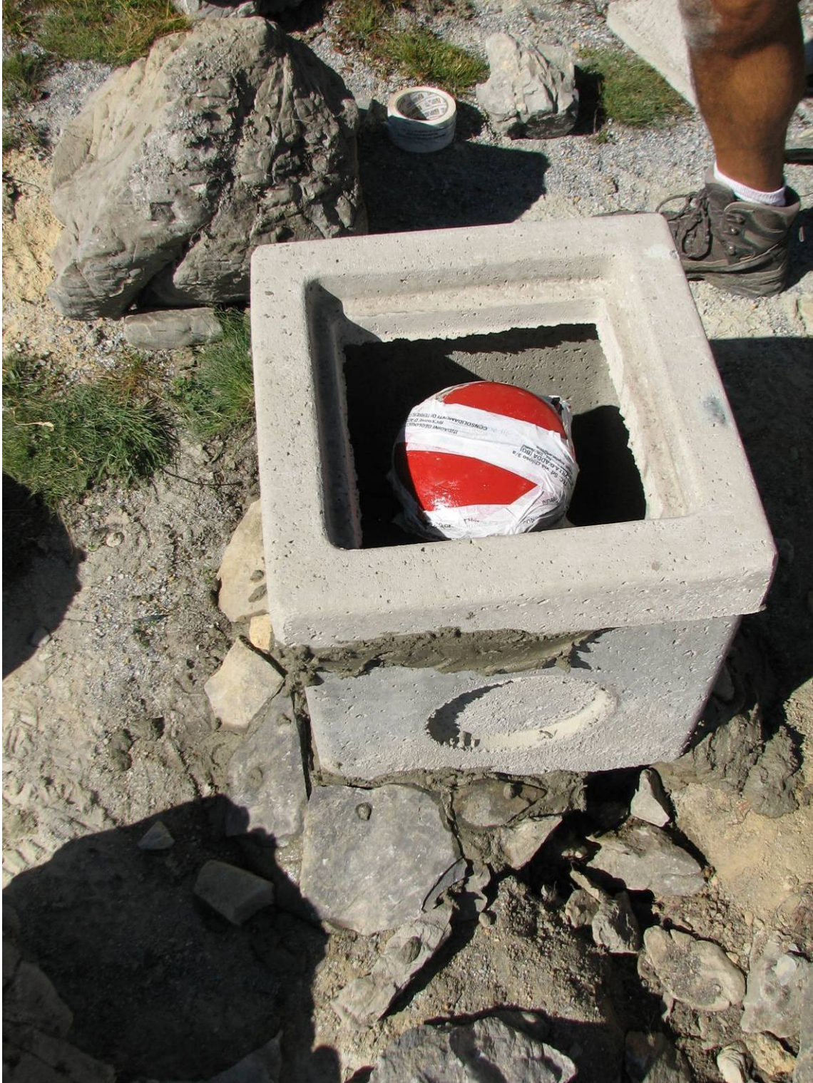
Sito del Passo della Gardetta (Canosio, CN) – Completamento del sopralzo testa-foro con protezione metallica e tombino in cls (foto: L. Paro, settembre 2011)
