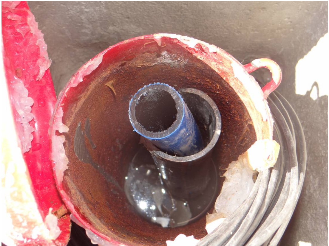
Sito del Passo della Gardetta (Canosio, CN) – Seconda fase di spurgo e inserimento di tubo di diametro ridotto all'interno del pozzo (foto: L. Paro, settembre 2013).
