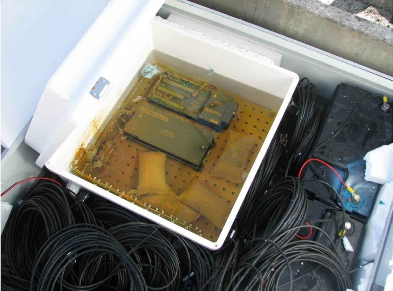
Sito del Passo del Monte Moro (Macugnaga, VB) – Verifica del danno alla strumentazione ed alle batterie a causa delle infiltrazioni di acqua che hanno provocato l'allagamento del tombino (foto: E. Fusetti, agosto 2010)
