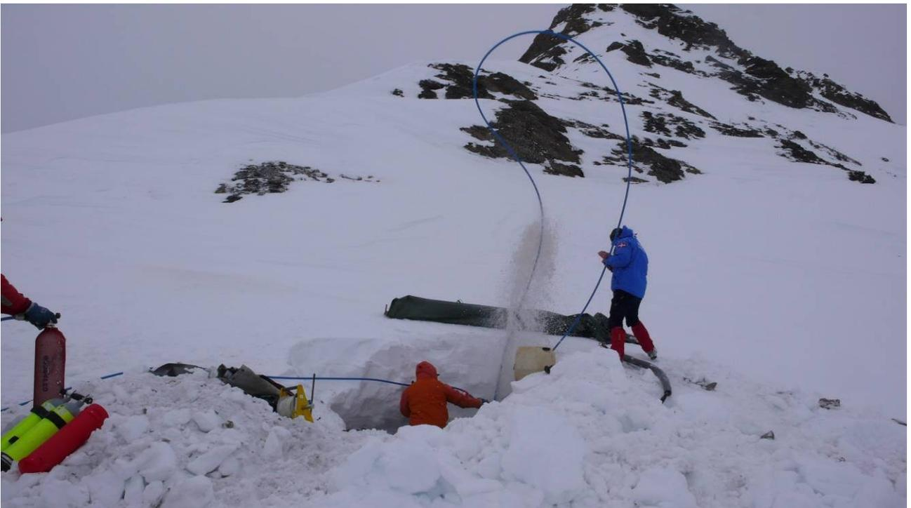
Sito de La Colletta (Bellino, CN) – Spurgo del pozzo profondo 30 m tramite acqua calda per sciogliere il ghiaccio (in alto) ed estrazione dell'acqua con aria compressa (foto: P. Mattiel, dicembre 2011)
