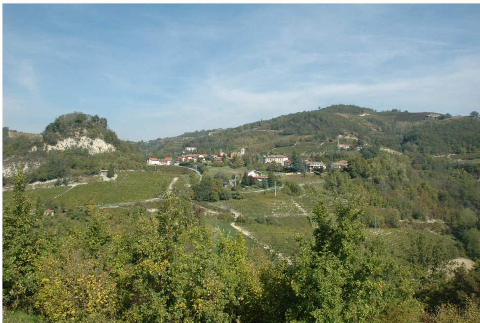
Immagine 01 - Panoramica dell'area in frana
