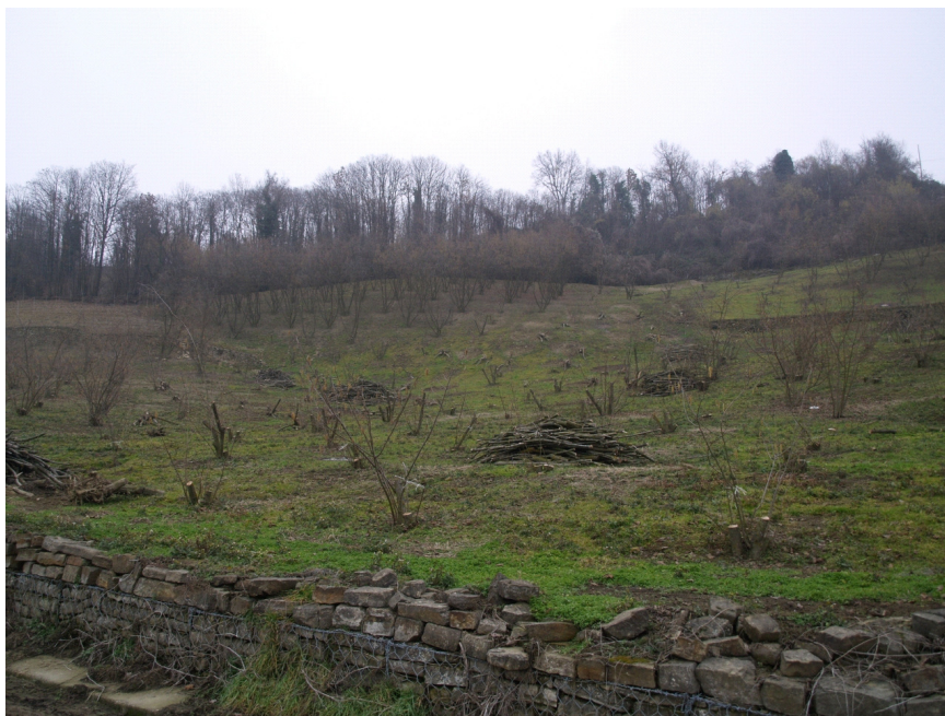
Immagine 01 - 2008/02/01-Settore destro idrografico del coronamento ripreso nei pressi di C.na Nova
