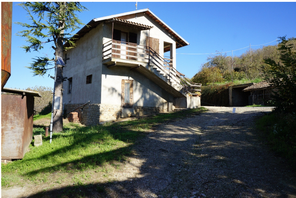
Immagine 06 - 2013/11/06-Località Ferrera; in primo piano sulla sinistra l'inclinometro automatizzato
