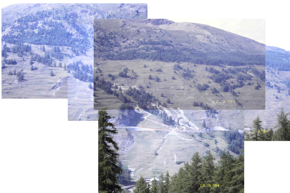
Immagine 02 - Comune di Sestriere, Loc. Borgata - Panoramica del versante oggetto degli interventi di drenaggio.
