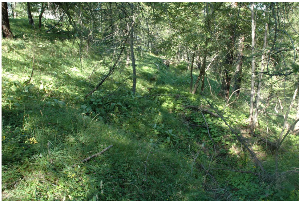
Immagine 01 - Recenti attivazioni del fenomeno nel settore superiore, fianco sinistro, a quota 1750 m (in prossimità dell'inclinometro S11)
