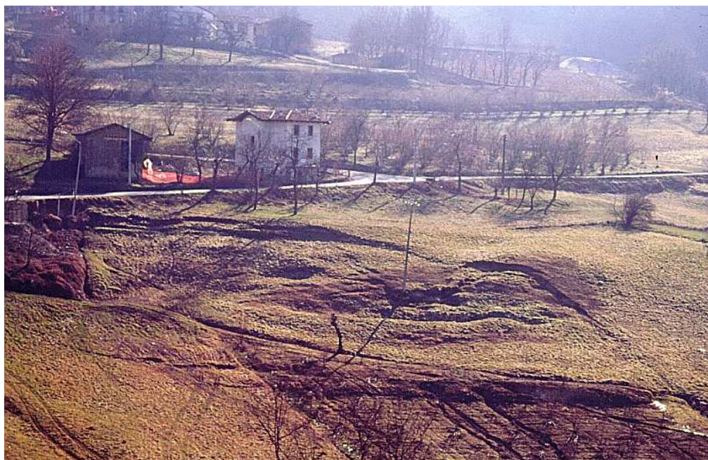
Immagine 04 - Vista parziale del settore superiore della frana (lo scatto è stato effettuato dal versante opposto in data immediatamente successiva all'attivazione del fenomeno).
