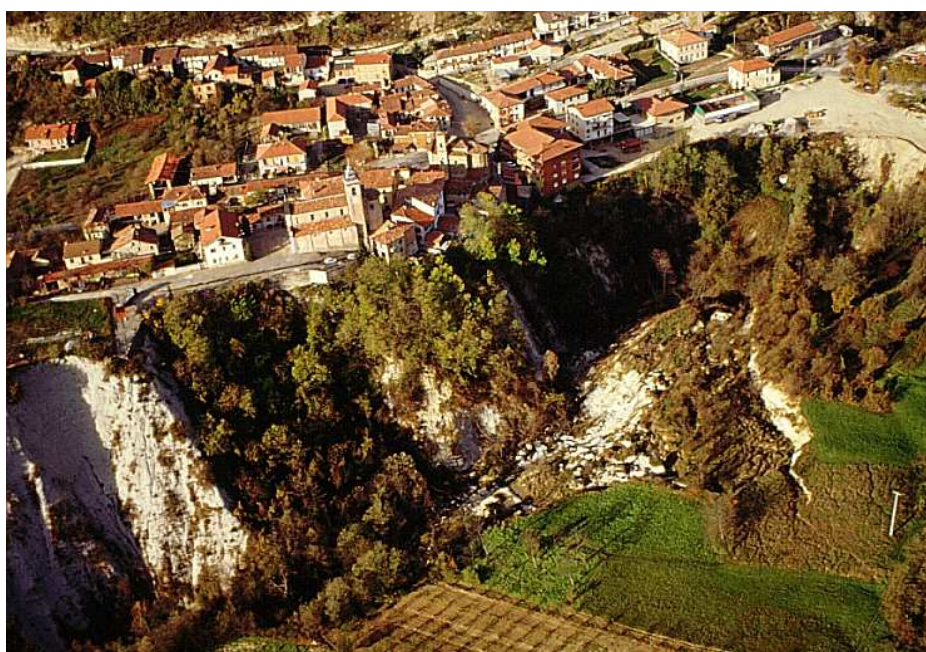
Immagine 02 - Settore mediano ed inferiore della frana (lo scatto è stato effettuato da elicottero in data immediatamente successiva all'attivazione del fenomeno).
