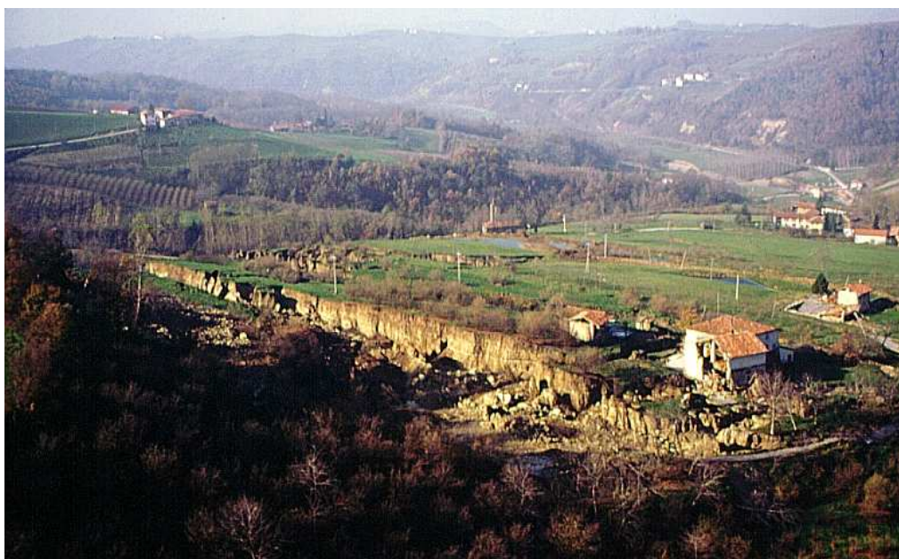
Immagine 04 - Trincea a valle del coronamento formatasi a seguito della traslazione della zolla su cui è ubicata la borgata Pianezza
