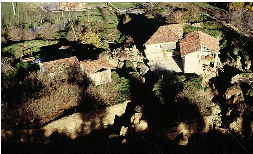
Immagine 09 - La borgata Pianezza quasi completamente distrutta dal movimento franoso
