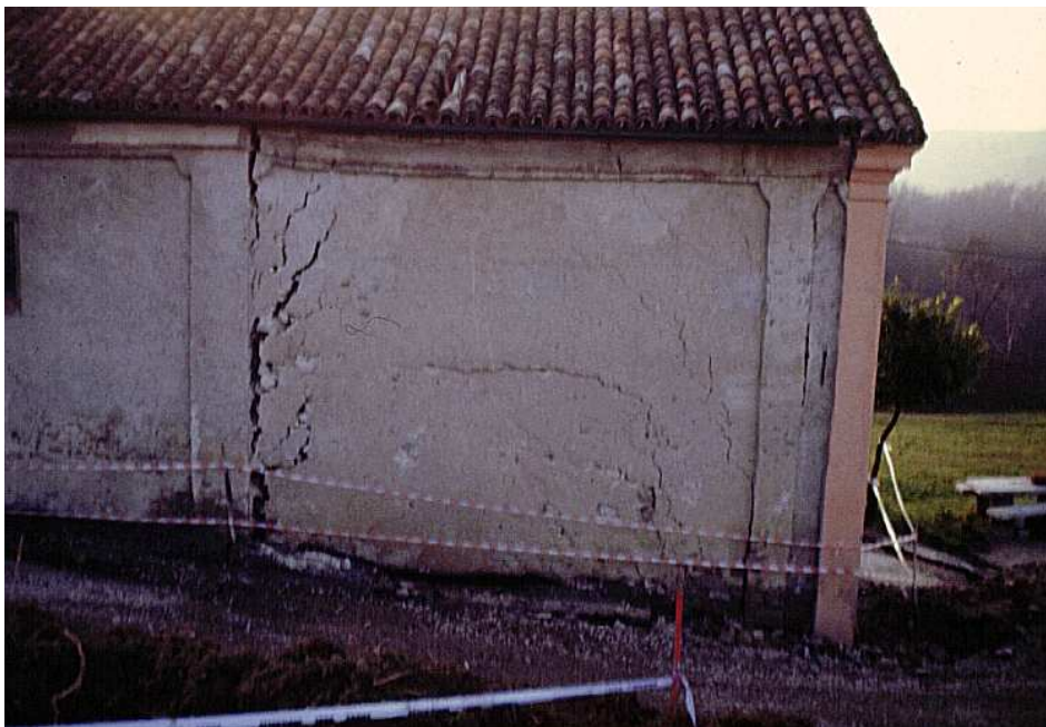
Immagine 16 - Particolare delle lesioni subite dai muri della chiesa di Madonna della Cassina
