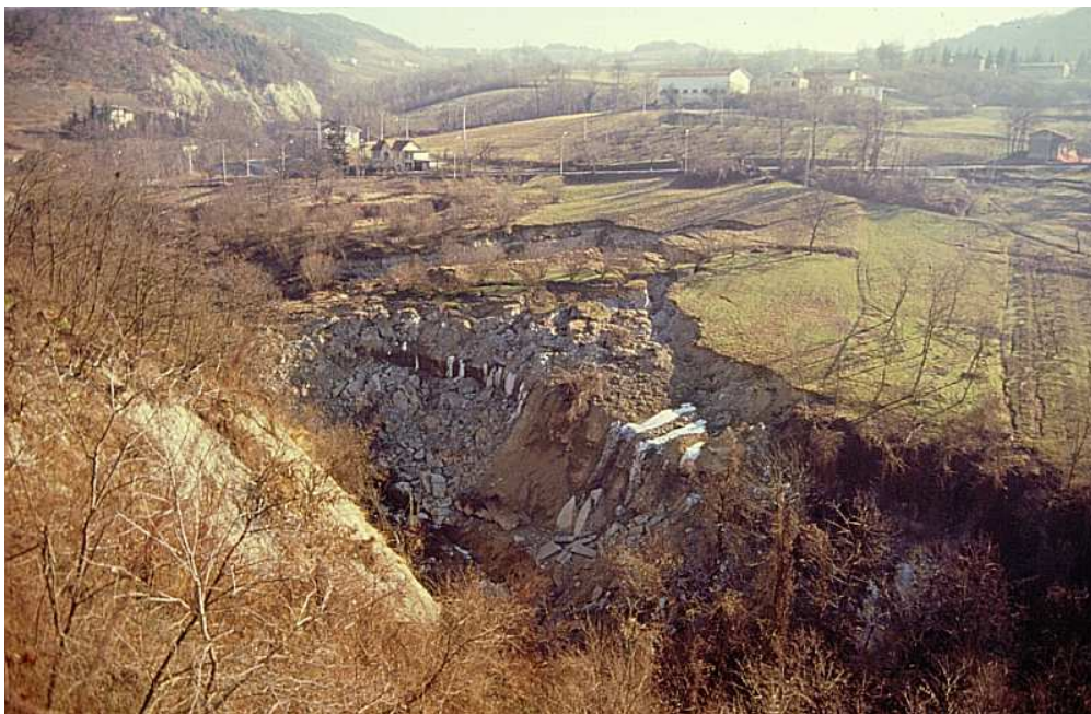
Immagine 03 - Panoramica dell'area in frana (lo scatto è stato effettuato dal versante opposto in data immediatamente successiva all'attivazione del fenomeno).
