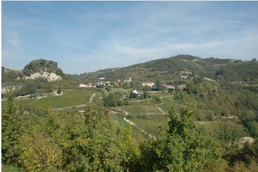
Immagine 01 - Panoramica dell'area in frana
