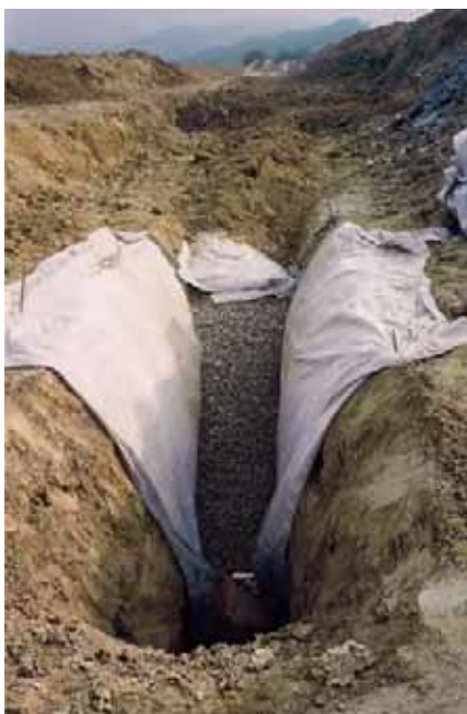
Immagine 08 - Trincea drenante in corso di esecuzione.
