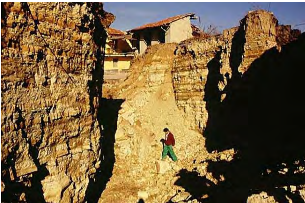
Immagine 07 - Zolle traslate e fabbricati distrutti.
