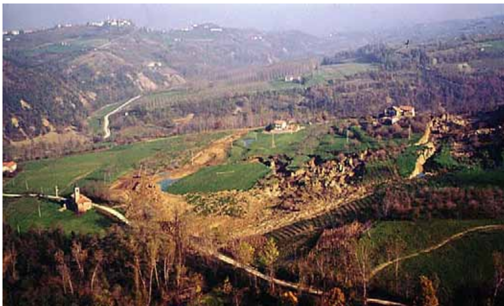
Immagine 03 - Lato e piede della frana
