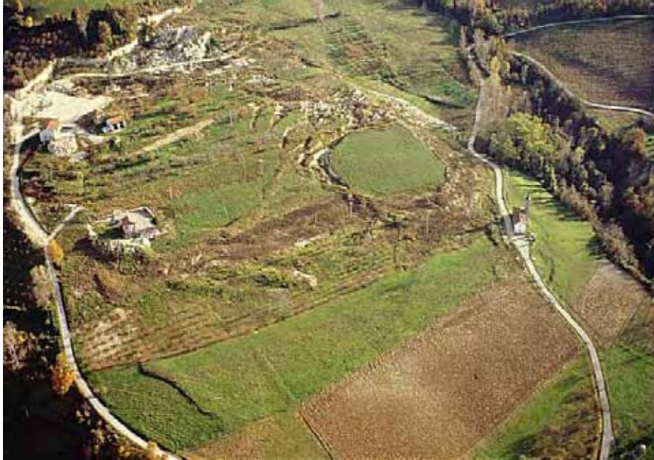
Immagine 01 - Vista generale della frana
