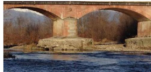
Particolare delle pile del ponte della SP3 sottoescavate
