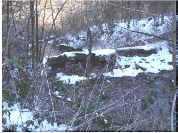
Vista da monte della traversa in disuso. Il "petto" è stato sottoescavato per aggiramento dell'opera .
