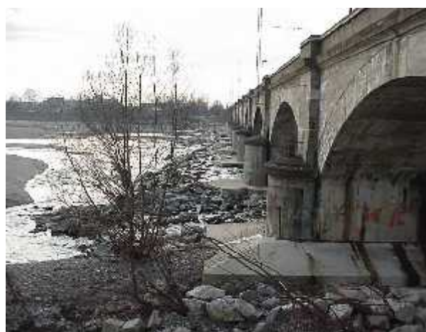
Ponte ferroviario a Vercelli
