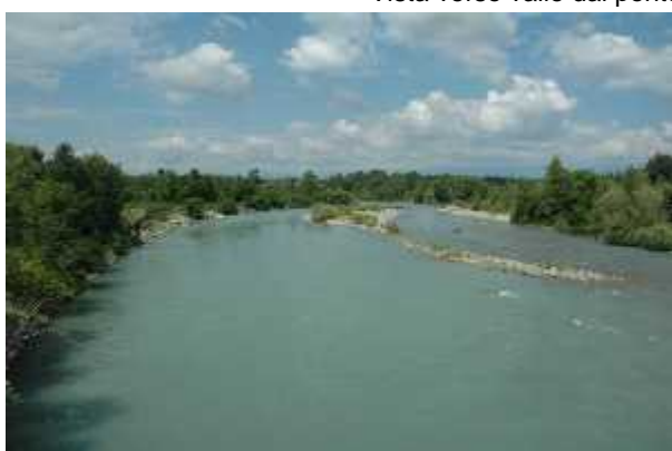
Vista verso monte dal Ponte di Rondissone.
