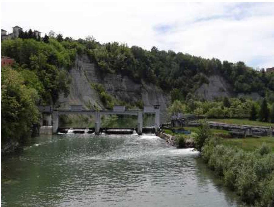
Traversa di derivazione Edison
