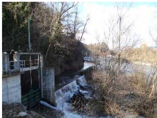
Canale di derivazione e traversa in secondo piano a monte del ponte tra Romagnano e Gattinara.
