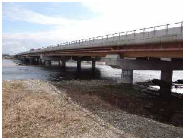
Il nuovo ponte autostradale.
