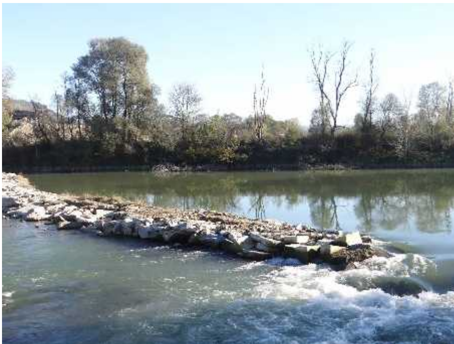
Traversa in massi a servizio dell'area in cava ubicata in sponda destra, poco a valle della confluenza del torrente Mondalavia.
