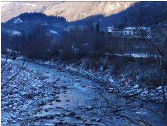
Tratto a ridosso dell'abitato di Balmuccia.
