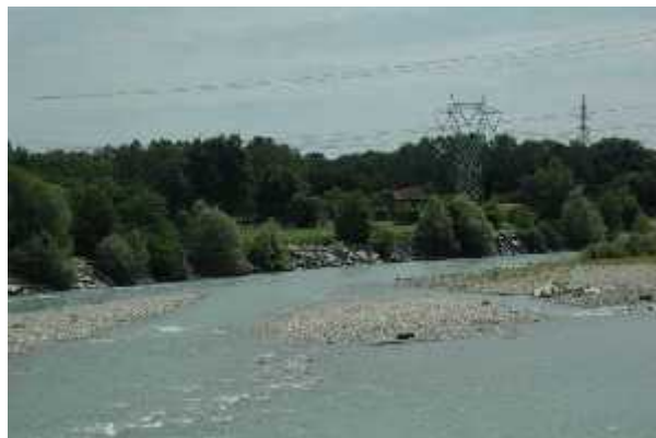
Vista verso valle dal Ponte di Rondissone; particolare della sponda sinistra protetta da opere di difesa.
