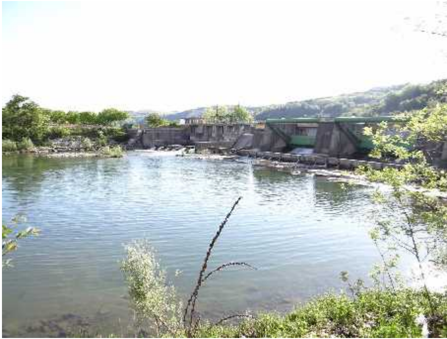
Vista ripresa da valle verso monte della diga dell'ex – Cottonificio di Clavesana
