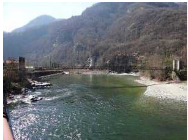
Vista da monte la traversa di derivazione in località Baraggiolo
