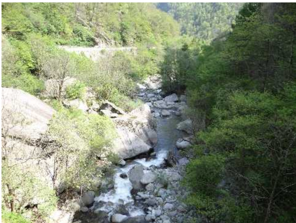
L'alveo a valle del ponte per Oncino.
