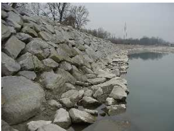
Difese spondali tra il ponte stradale e quello ferroviario.
