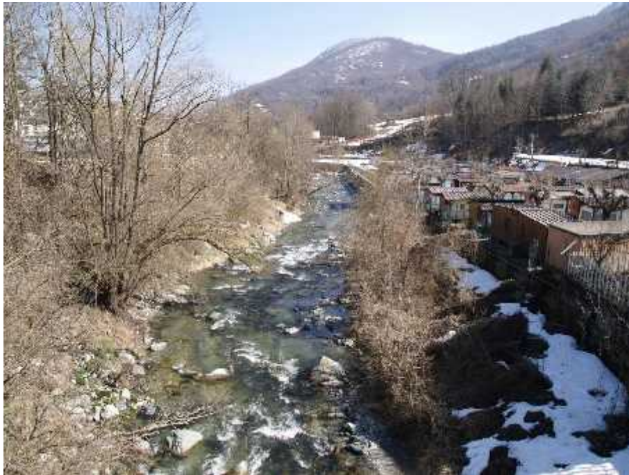
In destra idrografica si osserva il muro a protezione dell'area adibita a campeggio.
