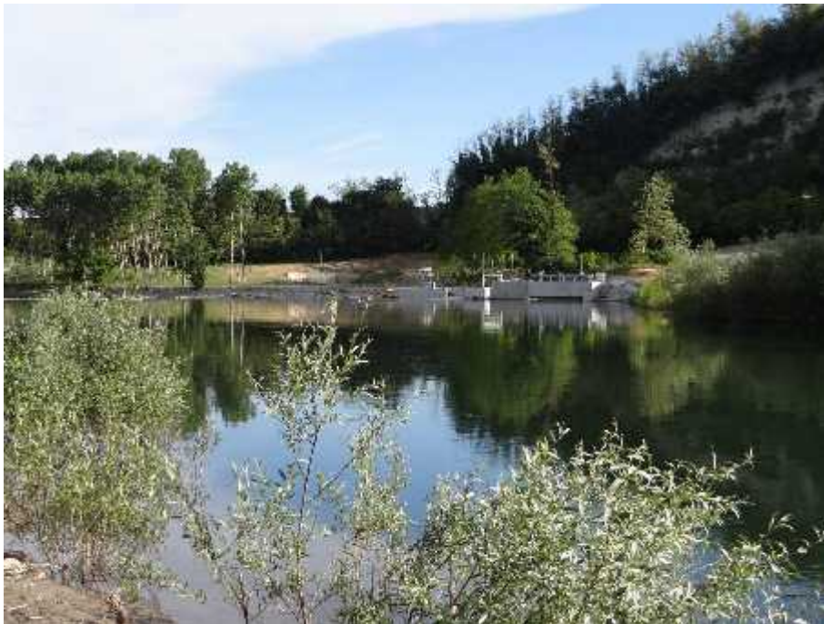
Opera di presa della centralina idroelettrica di recente realizzazione
