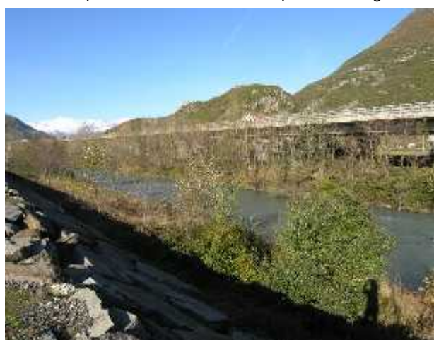
Sant'Antonino, scogliera e viadotto autostradale
