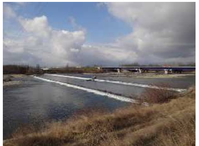
Il canale Cavour e le soglie a protezione dello stesso.
