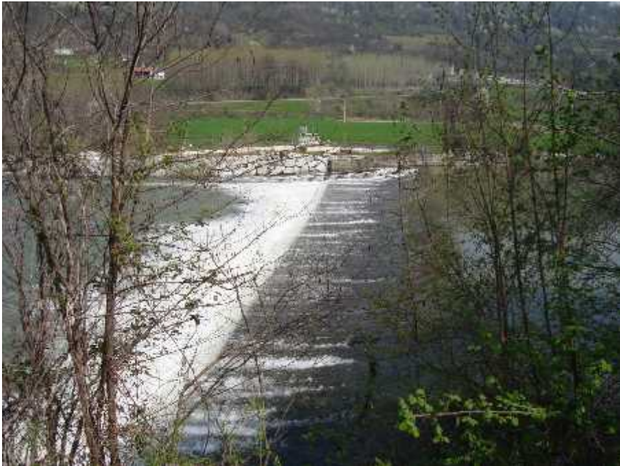
Traversa di derivazione immediatamente a monte dell'abitato di Bastia Mondovì (immagine gentilmente concessa dalla dott.ssa Zerbato)
