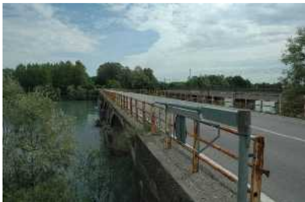
Vista laterale del ponte di Saluggia.
