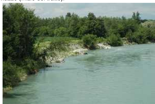
Vista verso monte dal Ponte di Rondissone. Particolare della sponda destra.
