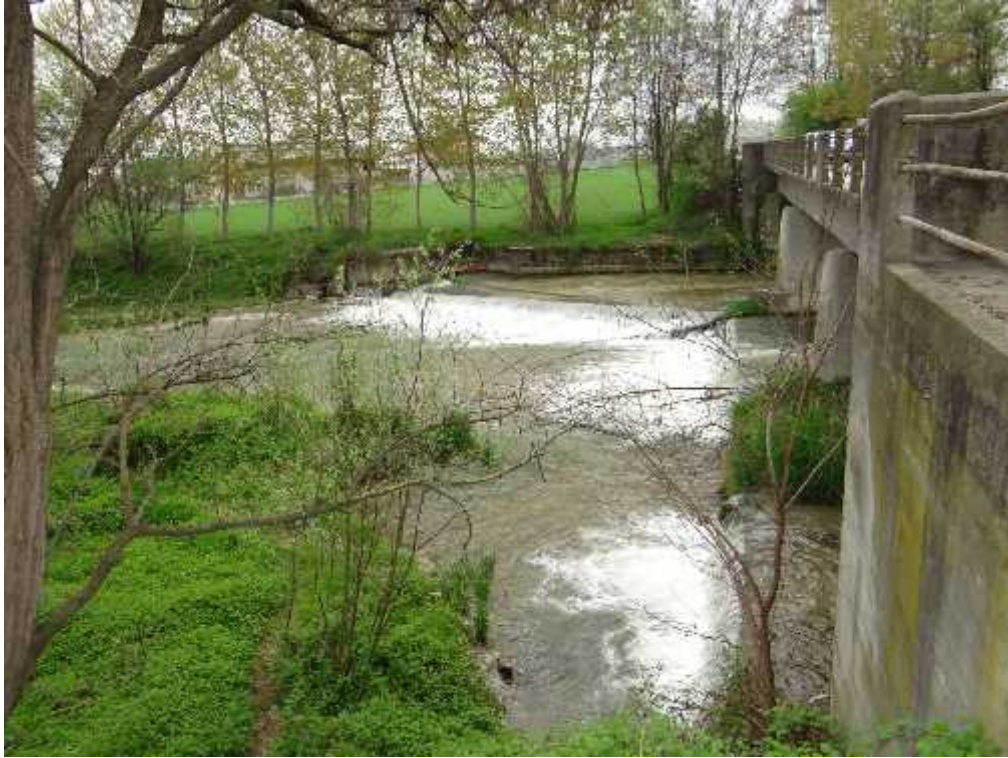
Attraversamento con soglia e opere di difesa all'inizio del tratto
