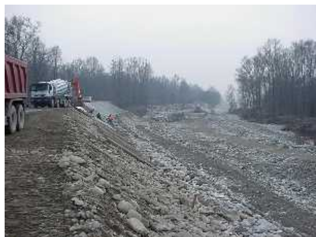
Lavori di riparazione dell'argine in fregio al corso d'acqua dopo la piena dell'ottobre 2000 (foto 2001).
