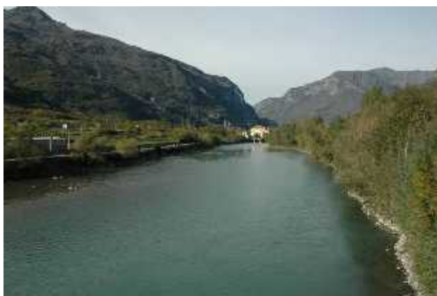
Vista verso monte dal ponte di Settimo Vittone; sullo sfondo la zona di confluenza con il T. Renanchio. Sponda destra completamente difesa.
