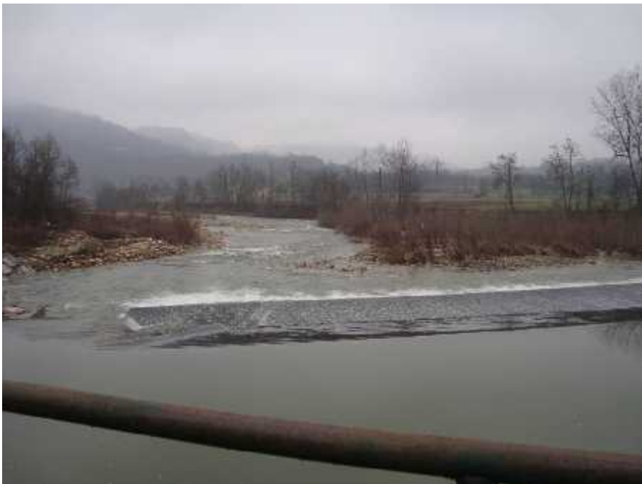
Traversa di derivazione al limite di valle del tratto (immagine gentilmente concessa dalla dott. Zerbatò)
