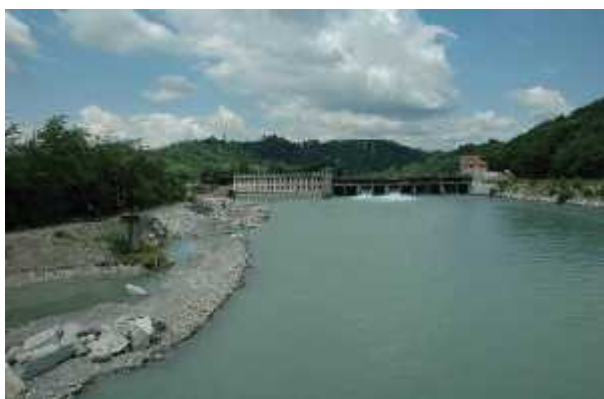
Vista verso monte della derivazione dal ponte di Mazzè.
