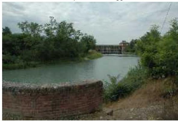
Derivazione del Canale Sussidiario Farini in sinistra idrografica, in prossimità del ponte di Saluggia.
