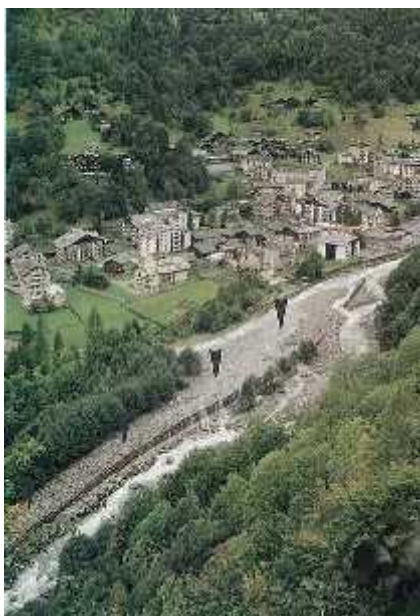
Difesa spondale in destra orografica sottoescavata in più punti subito a monte del campeggio di Alagna.
