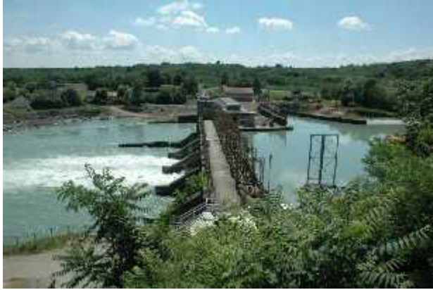
Vista laterale della derivazione di Mazzè ripresa dalla sponda sinistra.
