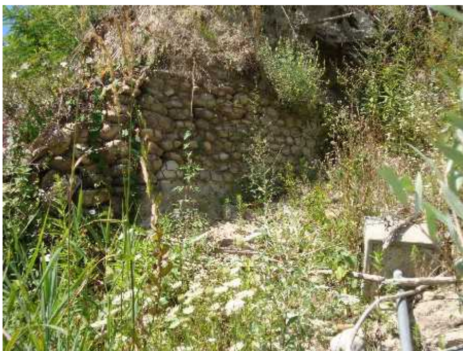
Antico pennello in massi, ormai non più connesso con l'alveo (immagine gentilmente concessa dalla dott.ssa Zerbato).
