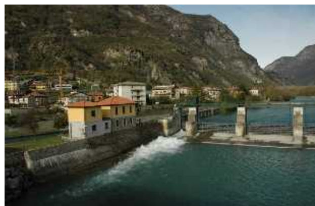
Particolare della traversa di derivazione all'estremità inferiore del tratto, in prossimità del ponte di Quincinetto.
