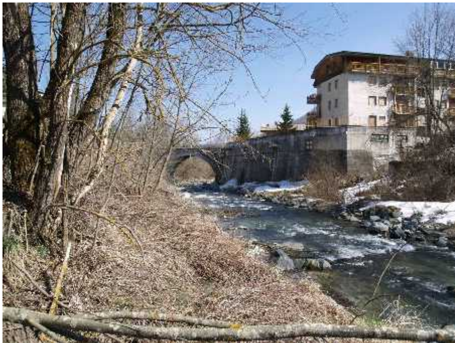
Ponte e muri di difesa in destra idrografica.
