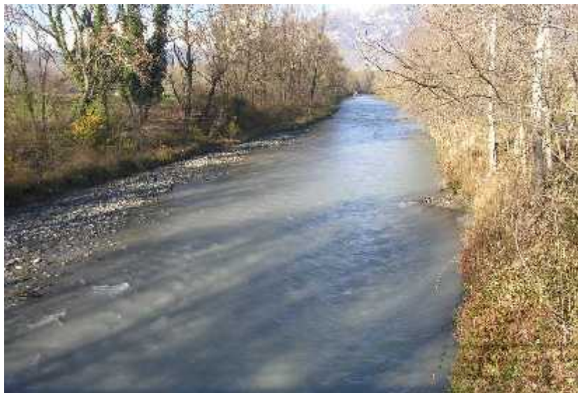
Regione Malpasso: porzione finale del tratto
