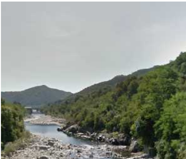
Alveo a valle del ponte di Isolella.
