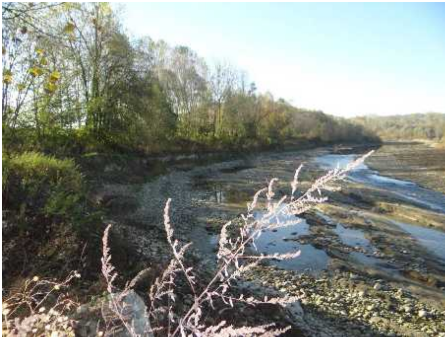
L'alveo in corrispondenza del ponte abbattuto lungo la strada provinciale per Monchiero. E' visibile l'affioramento del substrato roccioso.
