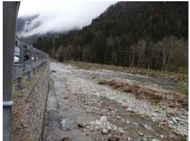
Argine sulla piana alluvionale
