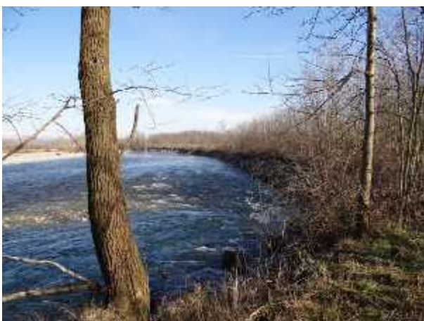
Sponda in erosione a monte dei due ponti precedenti.
