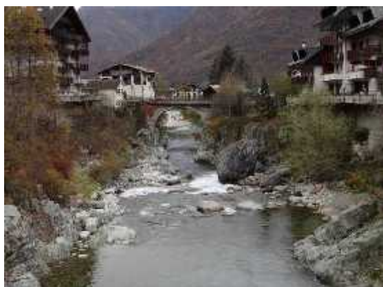
Restringimento dell'alveo in corrispondenza di Scopello
