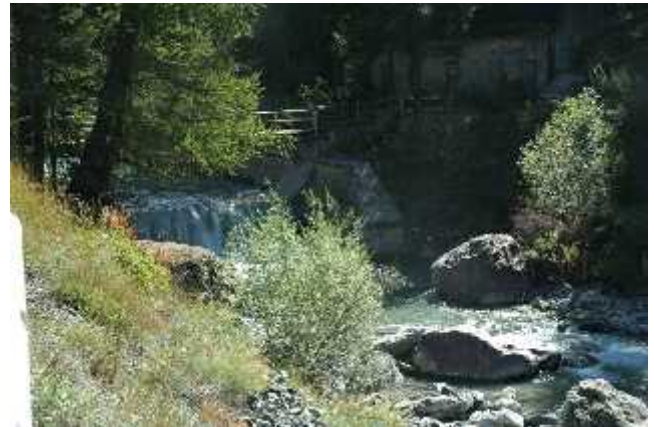
Opere trasversali a valle della strozzatura del fondovalle causata dai fenomeni gravitativi
