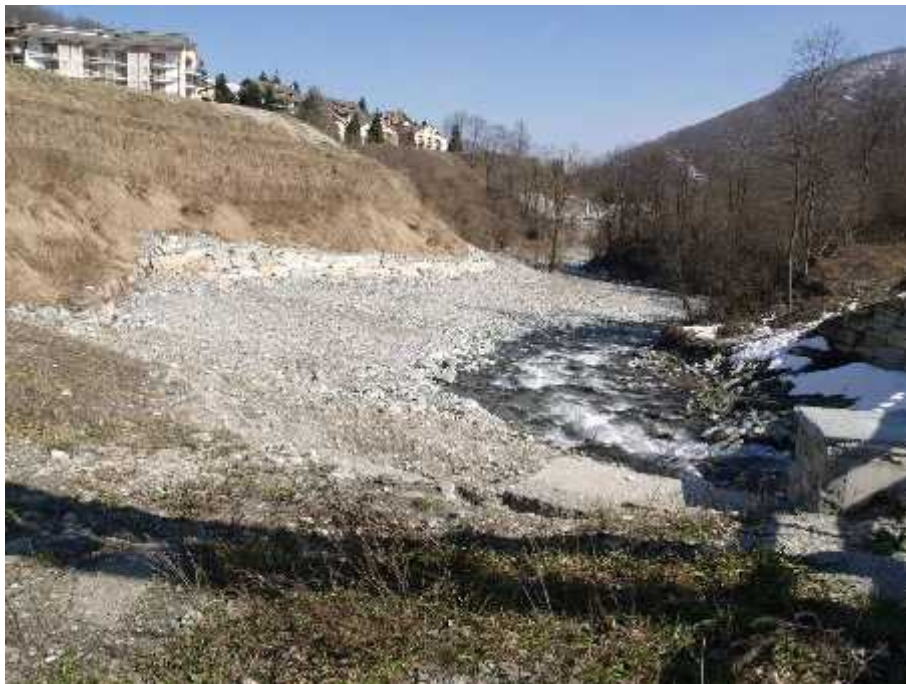
Difese spondali in sinistra idrografica, immediatamente a valle della passerella pedonale.
