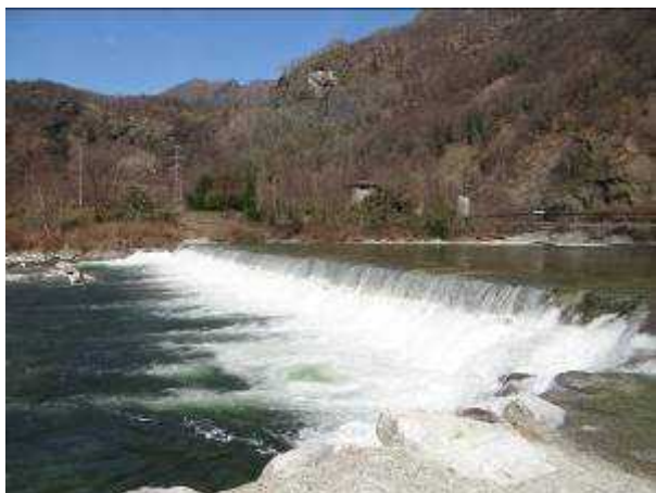
Vista da valle della stessa opera.
