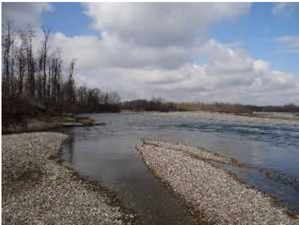
Vista dell'alveo con alcune erosioni di sponda.
