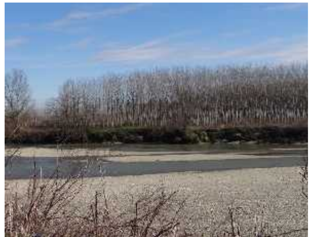
Sponde in erosione
