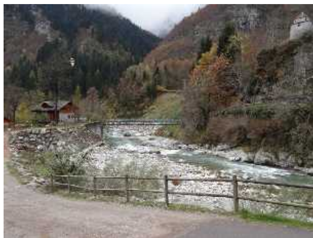
Gabbio- canale principale attivo in destra idrografica a partire dal 1988.
