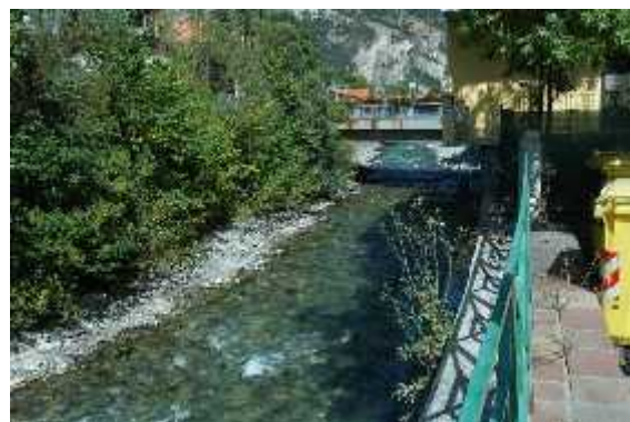
Ponte di Via Rolland a Oulx
