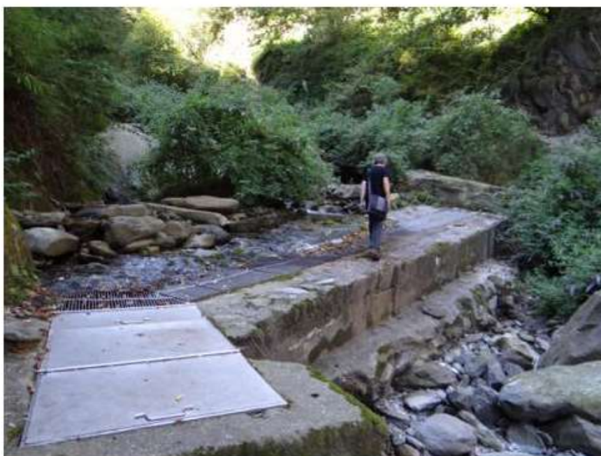
Figura 1. Opera di presa dell'acquedotto nel Comune di Pieve Vergonte.
