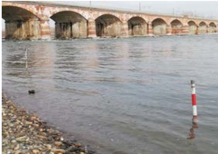
Figura 41 – Il Ponte della statale provinciale 294 a Valenza Po (AL)
