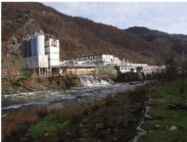
Difese di sponda presso area industriale di Malanaggio
