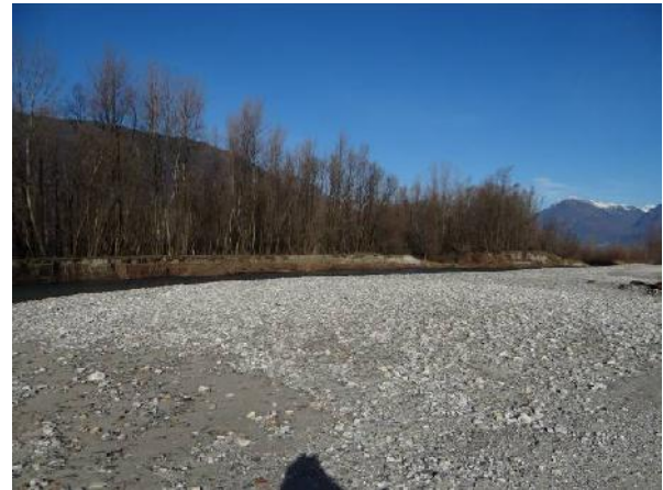
Estesa erosione spondale
