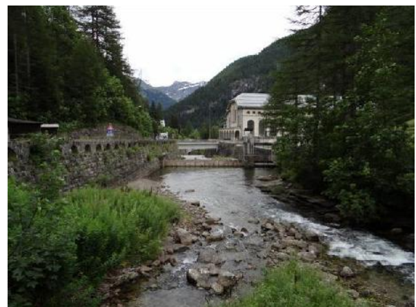
Traversa di derivazione di Ponte
