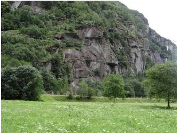
Argine in sponda destra da Balmerice a Caderese
