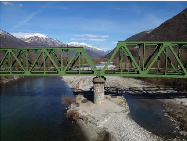
Il ponte della ferrovia.
