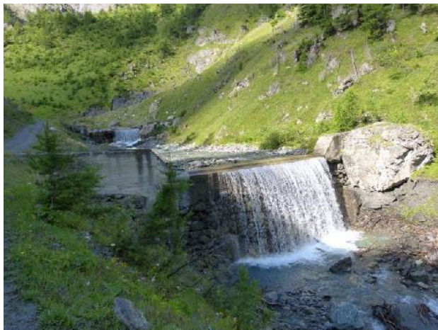
Briglie di trattenuta in calcestruzzo all'inizio del tratto
