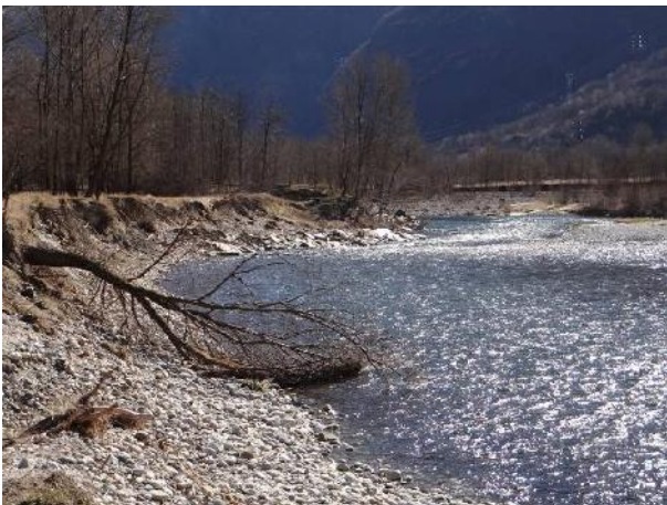
Erosione di sponda a monte di un vecchio pennello.
