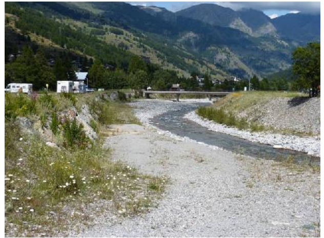
Difese spondali a monte di Pragelato
