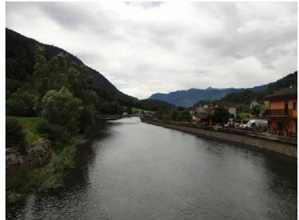
Difesa spondale in sponda destra prima della traversa di derivazione di Piedilago
