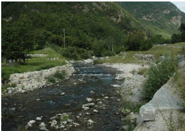
Loc. Balma, alveo visto verso monte entrambe le sponde sono difese
