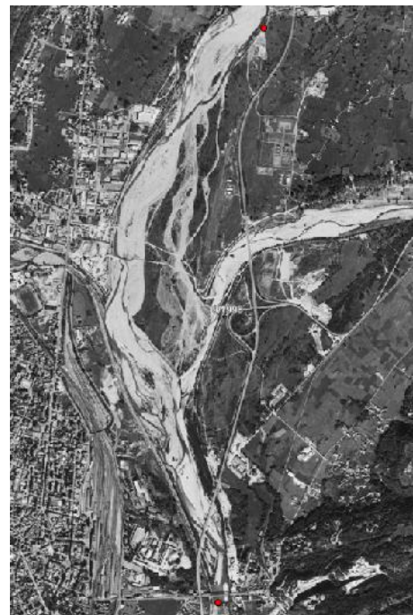
Prima della piena dell'ottobre 2000 l'alveo attivo scorreva in destra idrografica lambendo la zona industriale di Bisate. (Ortofoto, 1994-96)
