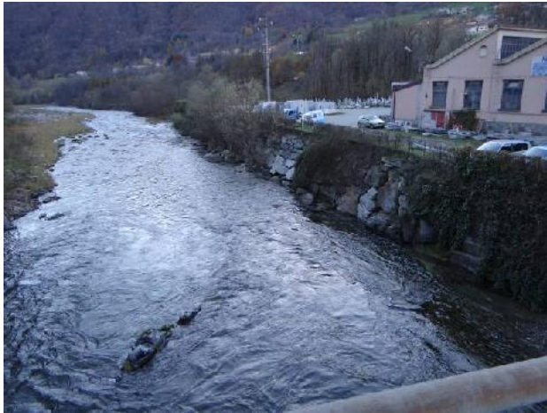
Dal ponte di S. Germano Chisone, inizio del tratto
