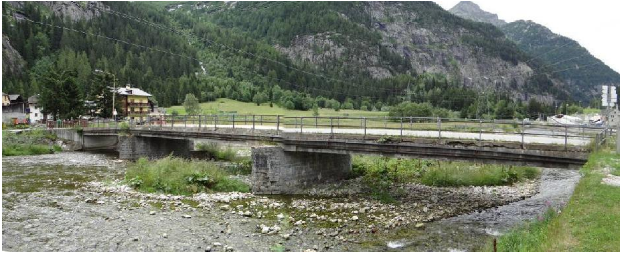
Ponte a Fondovalle
