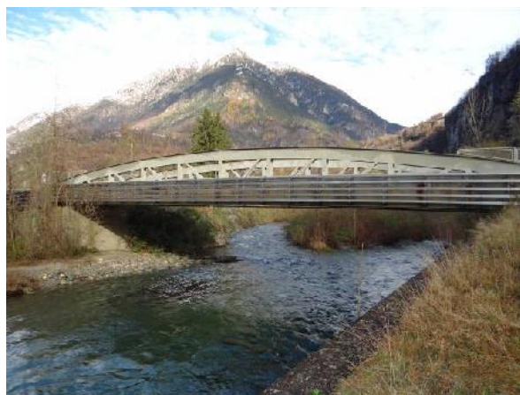
Ponte sul Toce a Verampio
