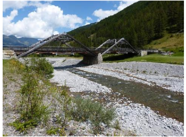
Nuovo ponte in corrispondenza di Traverses
