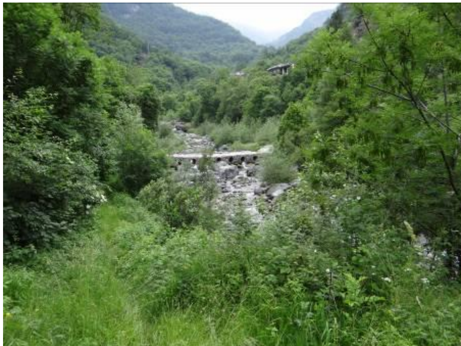
Figura 4 – Guado a sbarramento dell'alveo
