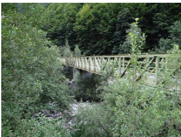
Passerella Pedonale sul Toce
