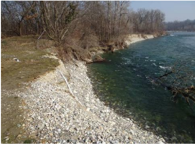
Erosione della sponda destra nei pressi di C. Tubi.
