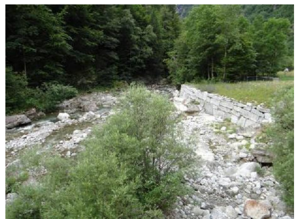
Difesa spondale in sponda destra
