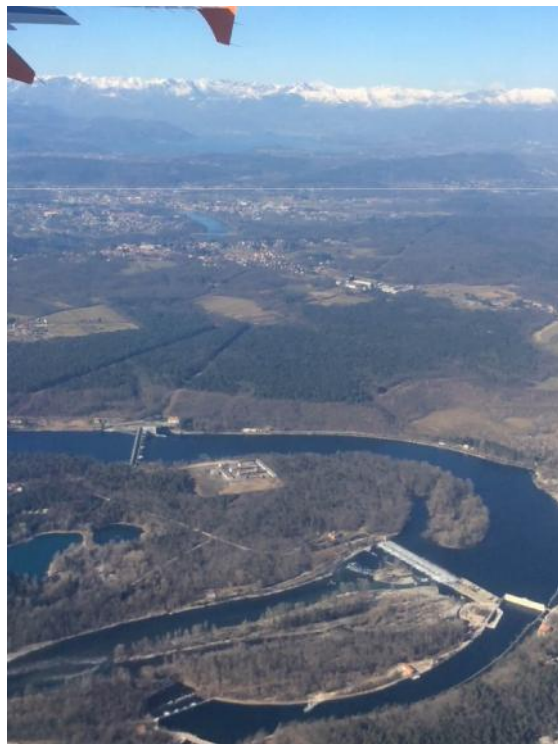
Vista area della traversa del Panperduto.
