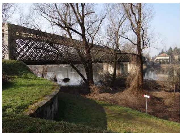
Il ponte di Oleggio.
