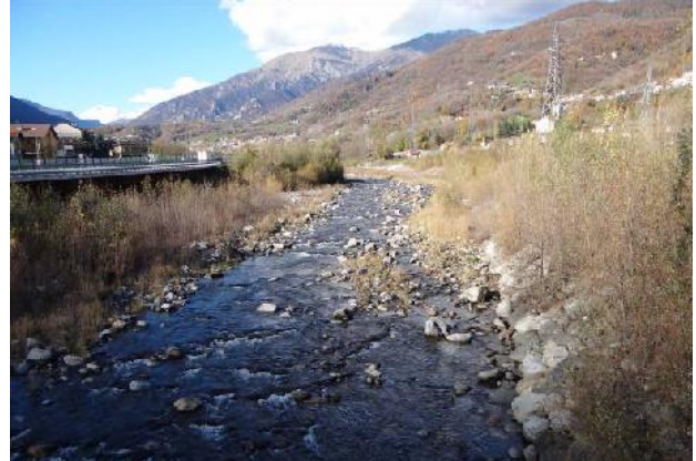
Vista verso monte dal ponte per Pinasca. Il viadotto della provinciale 166 poggia sulla sponda destra
