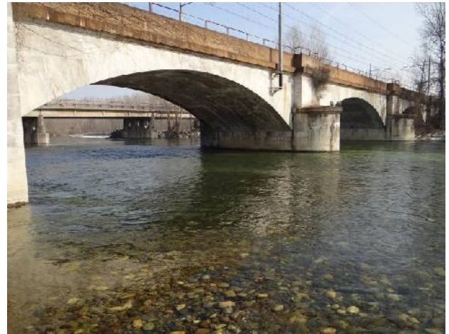
Ponte della linea ferroviaria.
