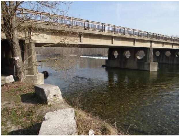
Vista del ponte sul Ticino della SS 11.
