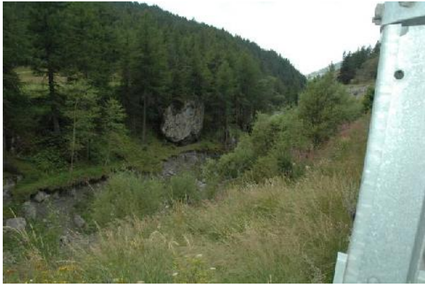
Sponda destra erosa vista dalla statale
