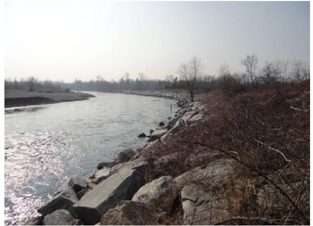
Difese spondali in località M.o Vecchio.
