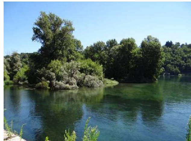
Vista verso monte della traversa.
