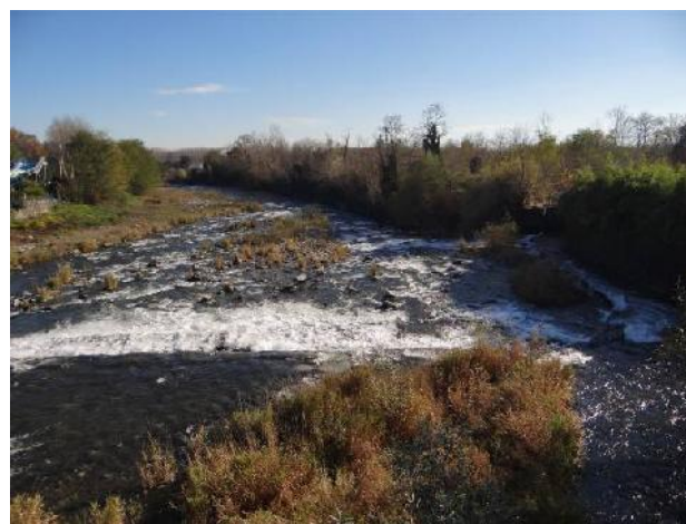
Alveo visto verso monte dal ponte di Miradolo
