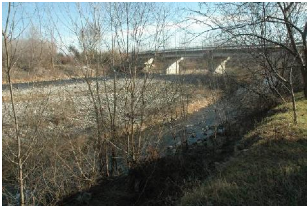
Ponte della SS del Sestriere a poca distanza dal ponte ferroviario
