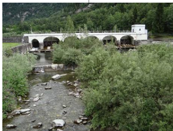
Traversa di derivazione di Piedilago con soglia
