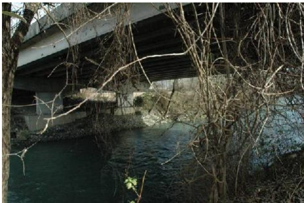
Ponte C.so Sacco e Vanzetti (Collegno)
