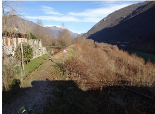
Argine in sponda sinistra a monte del ponte della Masone
