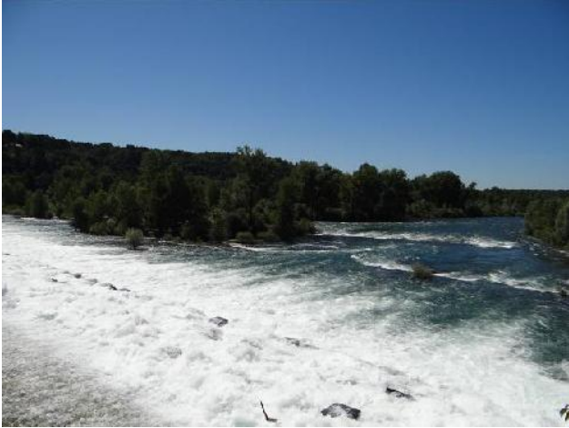
Inizio del secondo tratto a valle della traversa da cui ha origine il canale Villorosi.
