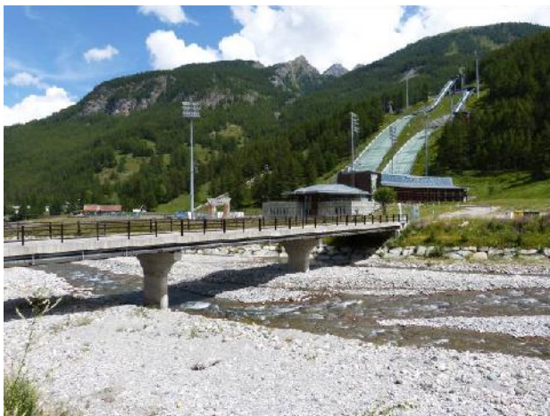
Ponte e difese in corrispondenza dei trampolini a Pragelato
