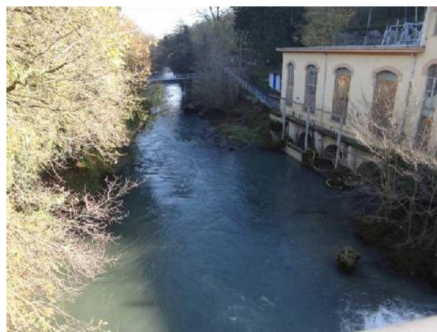
Alpignano, centrale con presa per uso energetico
