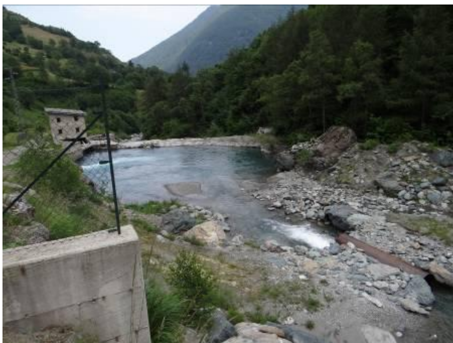
Figura 1 – Sbarramento per centralina idroelettrica
