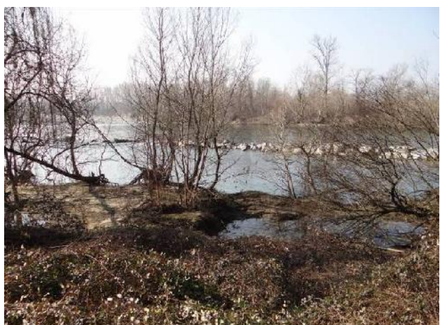
Vista dell'alveo con alcune erosioni di sponda.
