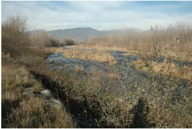
Sponda destra con difese a monte del doppio attraversamento ferroviario e stradale
