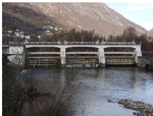
Traversa di derivazione di Crevoladossola
