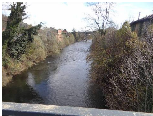
Il ponte della Provinciale 166 visto dal precedente
