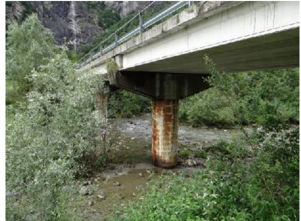
Pile ponte sul Toce a valle di Caderese
