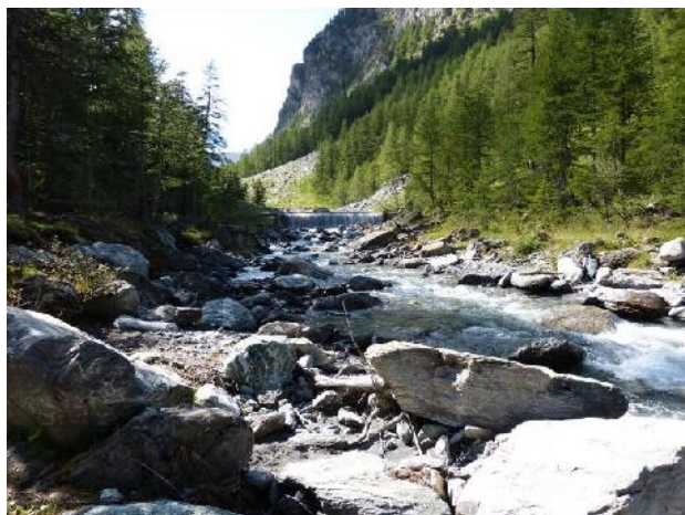
Vista verso monte in corrispondenza di Troncea, visibile una briglia di trattenuta in calcestruzzo
