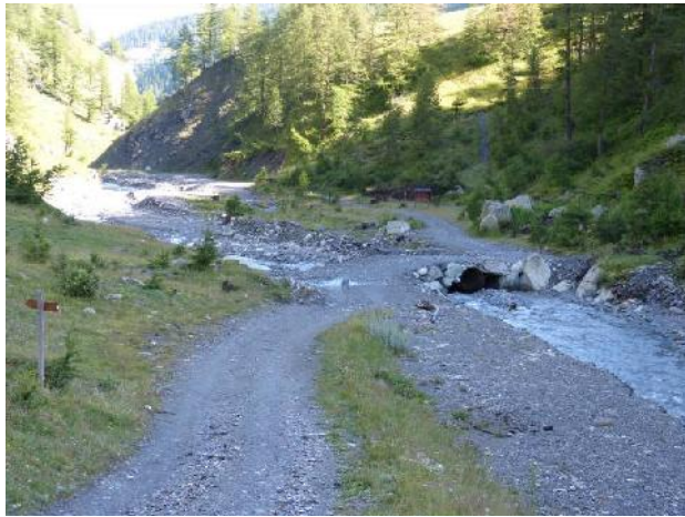
Attraversamento della strada forestale
