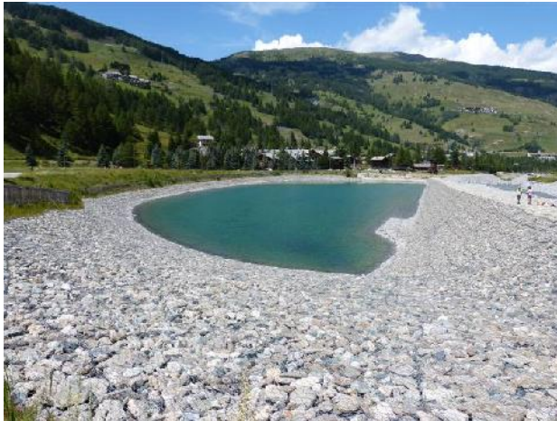
Bacino di accumulo per innevamento artificiale di Pattendouche
