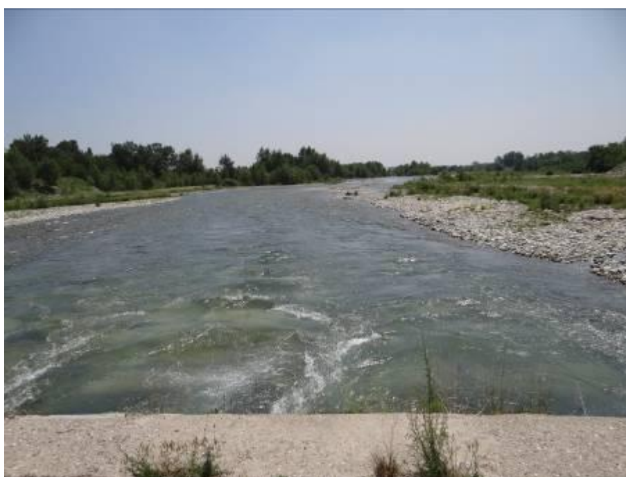
Figura 2 – Alveo a valle del guado in prossimità della confluenza con il torrente Chisone
