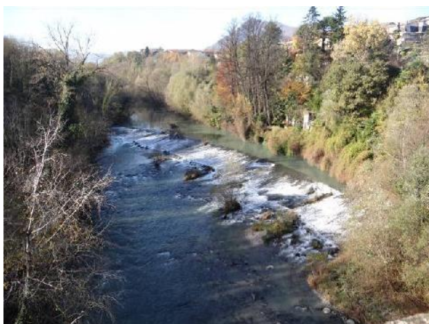
Traversa di derivazione a monte del ponte della SP 177 ad Alpignano
