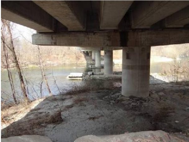
Basamenti erosi a protezione delle pile del viadotto della superstrada nei pressi di Albo.
