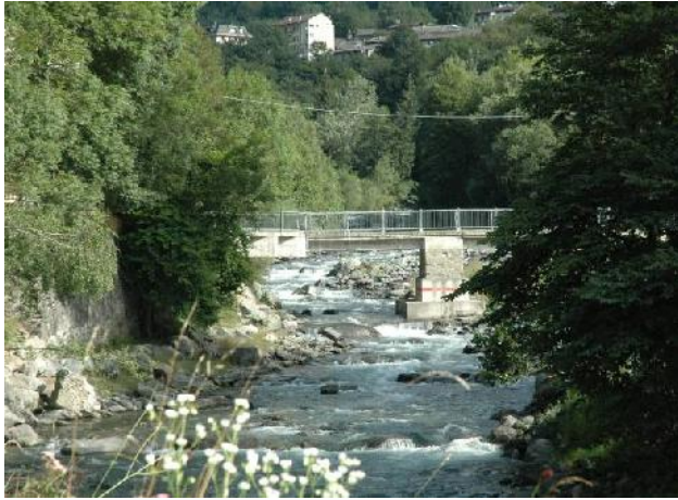
Ponte di loc. Gleisolle (Villaretto)
