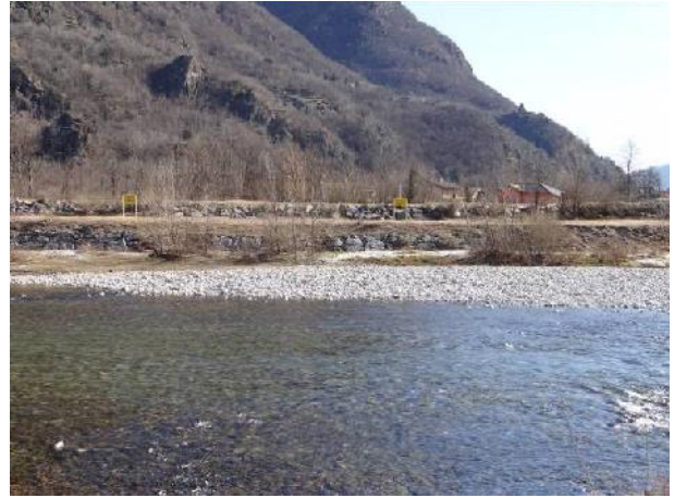
Difese spondali e argine in sponda sinistra.
