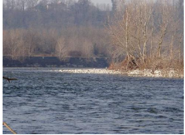
Difese spondali in massi ciclopici nei pressi dello stabilimento Balkem Italia.
