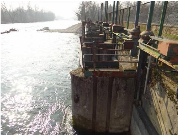
Presa del canale Nuovo.
