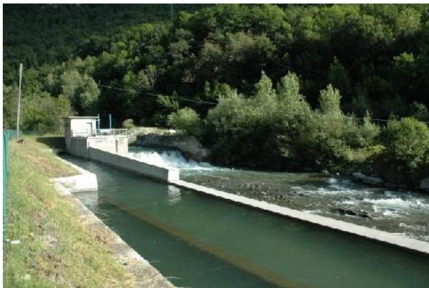
Traversa e canale di derivazione del bacino di Villaretto
