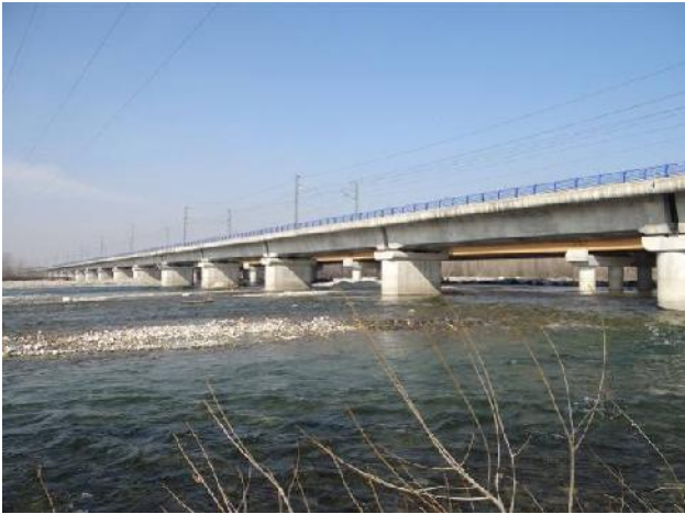
Vista dei due viadotti che attraversano il Ticino.
