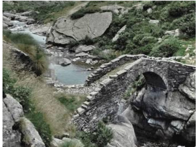
Il ponte a monte del guado.
