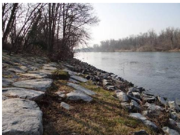
Argine in fregio al corso d'acqua.
