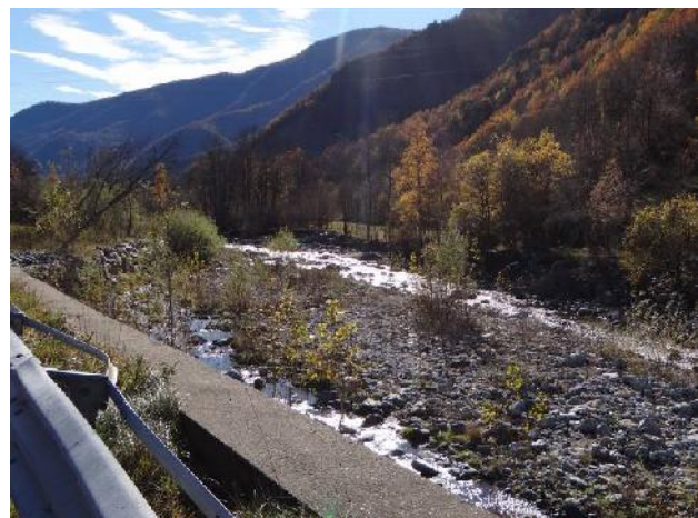
Balma, vista dall'argine a difesa della strada
