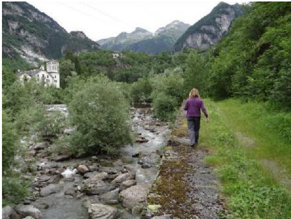
Argine sulla sponda sinistra in loc. Rivasco
