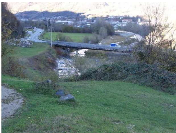
Attraversamento della Strada Provinciale 166
