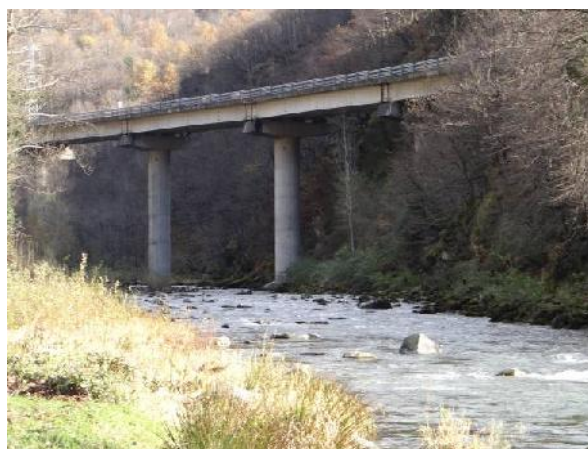
Viadotto superstrada prima dell'entrata in galleria
