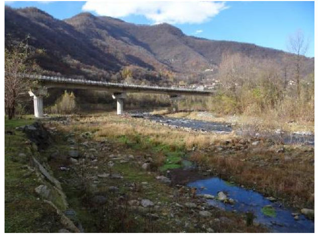
Ponte della Statale
