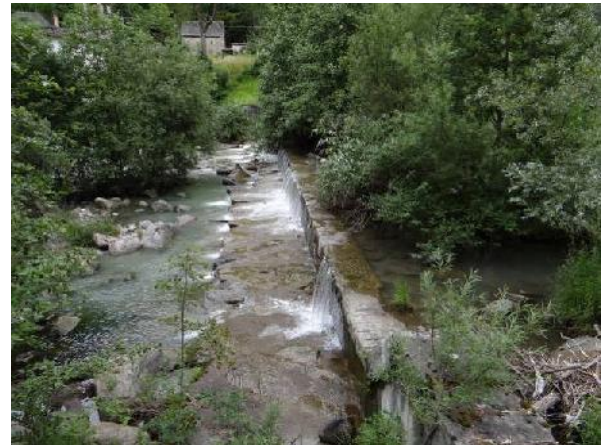
Soglia sottoescavata in loc. Rivasco, a monte del ponte
