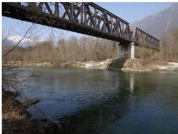
Ponte ferroviario di Beura.
