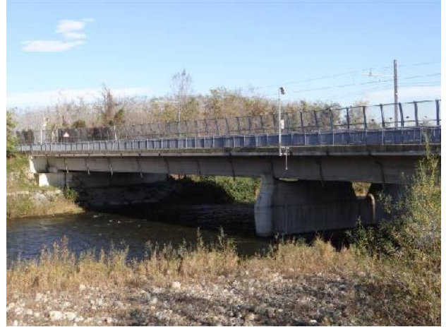
Doppio attraversamento stradale e ferroviario
