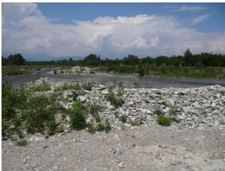
Figura 8 – Alveo a monte del guado (interrotto) in comune di Garzigliana, località Cavour
