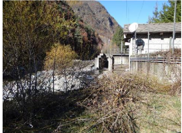
Opera di presa a valle della restituzione della condotta forzata in loc. Lombrese
