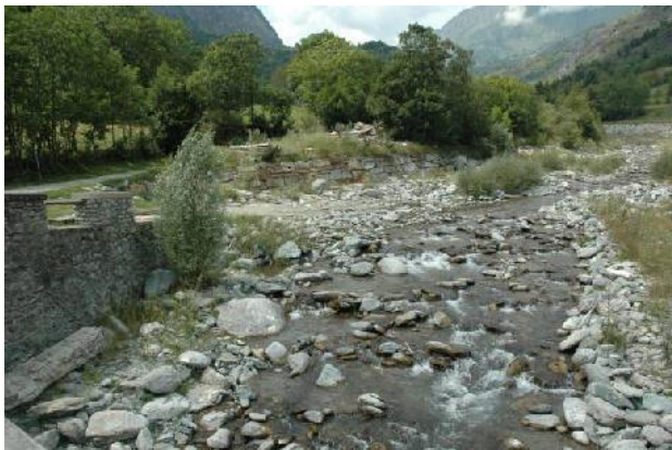
Dal ponte a monte di Fenestrelle, vista verso monte
