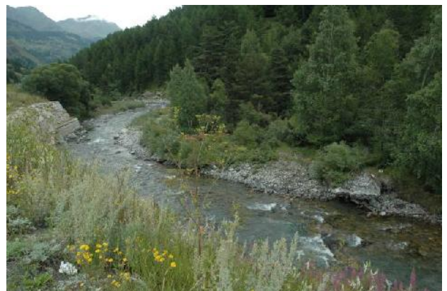
Alveo con difesa in sponda sinistra, al termine del tratto
