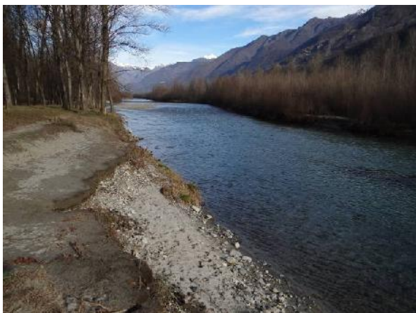
Erosione sponda idrografica destra
