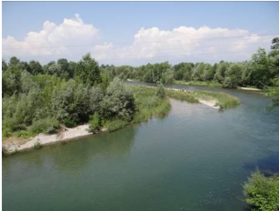
Figura 5 – Alveo a monte del ponte Villafranca Piemonte – Vigone
