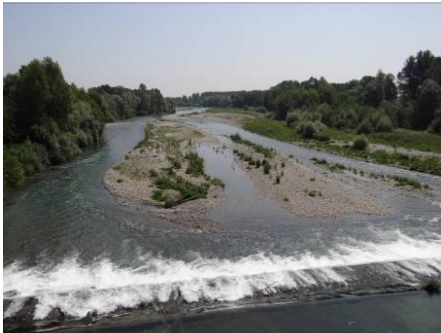
Figura 6 – Alveo a valle del ponte Villafranca Piemonte – Vigone (Inizio tratto); in primo piano la soglia a valle del ponte
