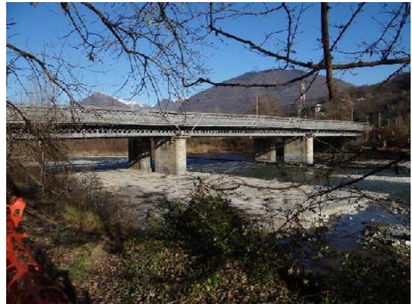
Ponte Mizzocolla sul fiume Toce, nei pressi di Domodossola.
