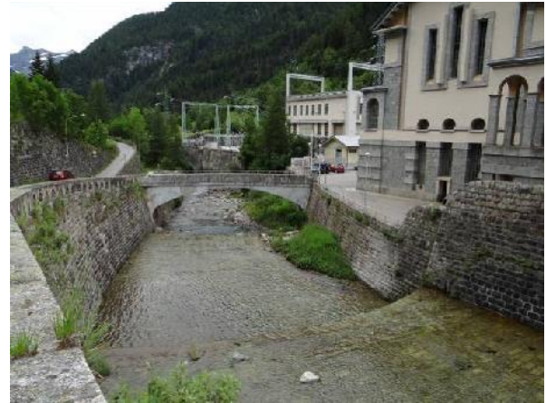
Tratto di alveo canalizzato con serie di soglie
