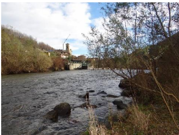
Traversa e opera di presa a monte di Porte
