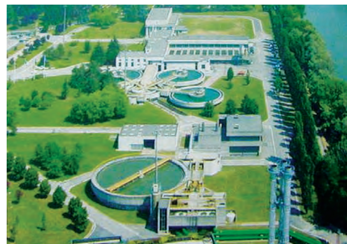
IMPIANTO DI POTABILIZZAZIONE DELLA SMAT (TORINO)
