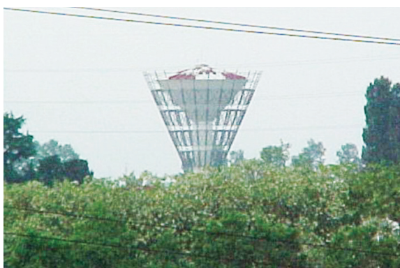
Figura 2.9 - Torre Piezometrica Fonte: Smat
