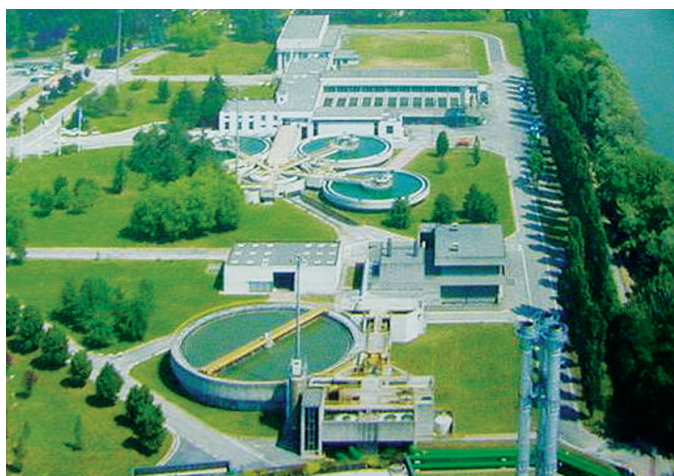
Figura 3.1 - Impianto di potabilizzazione della Smat (Torino) Fonte: Società Metropolitana Acque Torino
